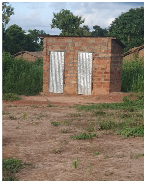
Construction de toilettes (Rentrée 2023)
